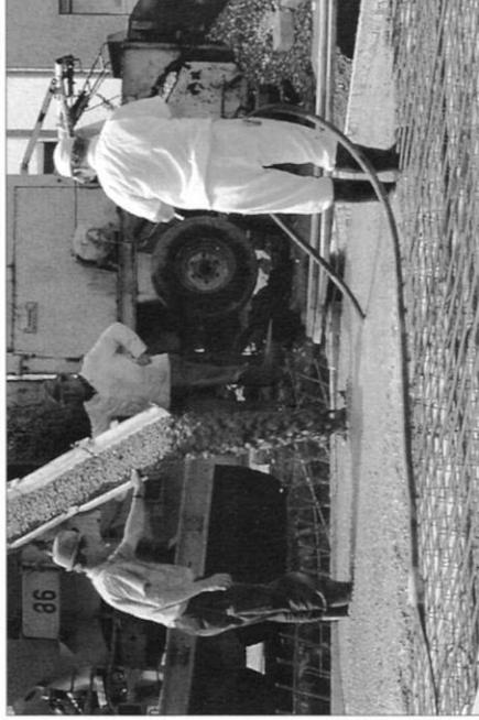
Verarbeiten Sie den Transportbeton unmittelbar nach seiner Anlieferung. Ist der Beton in der Schalung, muß er verdichtet werden. Bei der Verdichtung entweicht die eingeschlossene Luft; dies reduziert die Bildung von Poren. Nur gut verdichteter Beton erreicht seine vorgesehene Endfestigkeit.
